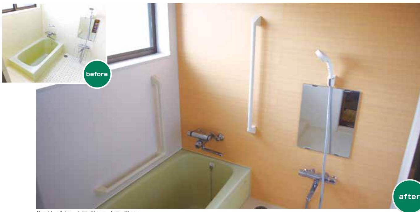
施工例 手すり：左面L型600、右面I型800
