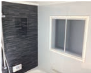
フクマド 施工後
