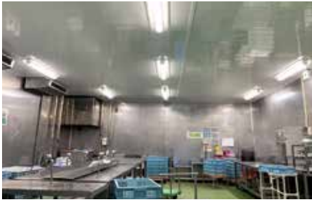
水産加工工場 (使用箇所: 加工場 天井)
