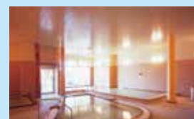
浴室 天井・壁
