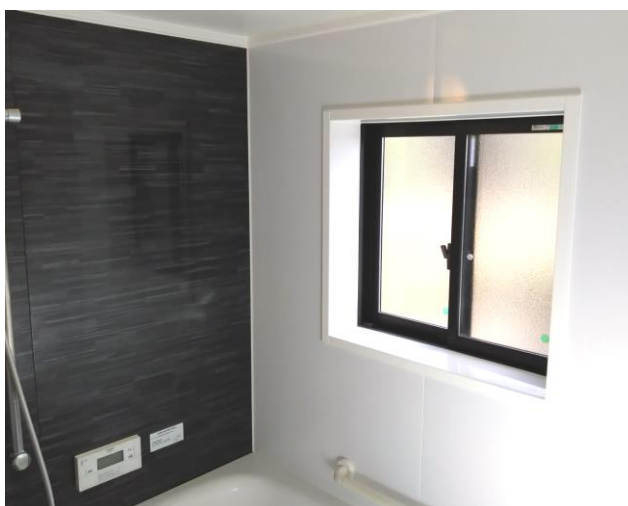
フクマド 施工前（外窓のみ）
