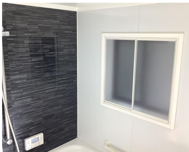
フクマド 施工後
