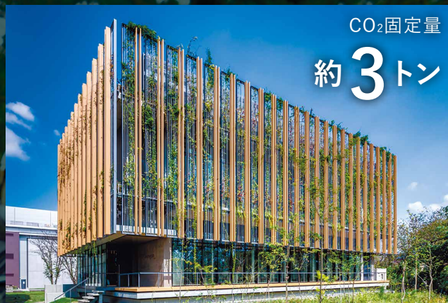
戸田建設グリーンオフィス棟
