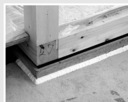
アリダンコーキング SH1500施工
