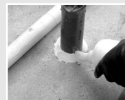
配管周りの処理
