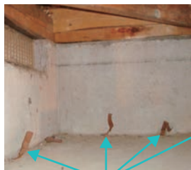
こうした、型枠固定金具の腐食部分は、シロアリが更に侵入しやすくなります。
