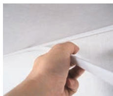
クロス貼り後カバー取付け
