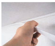
クロス貼り後カバー取付け
