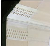
下地角度に沿うように、製品を折り曲げ、押し当てるようにして位置を合わせ、テープで貼付け
