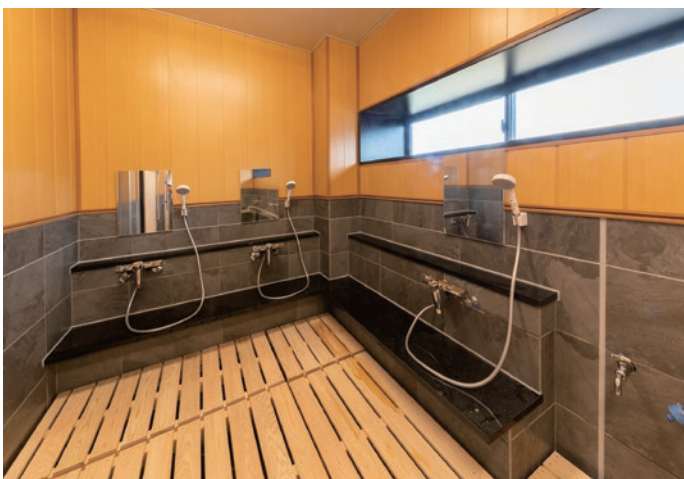
物件名/温泉 (使用場所/浴室 天井・壁)
