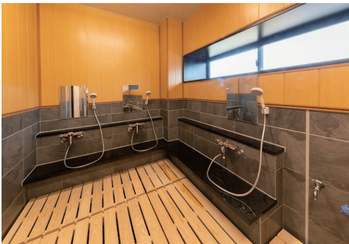
物件名/温泉 (使用場所/浴室 天井・壁)
