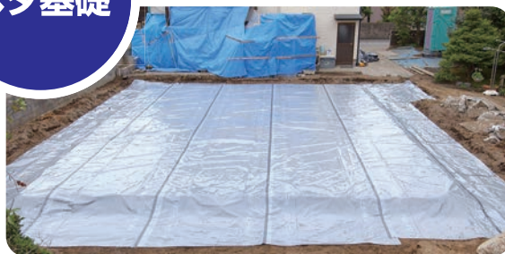
シート工法 (アリダンシート工法)
