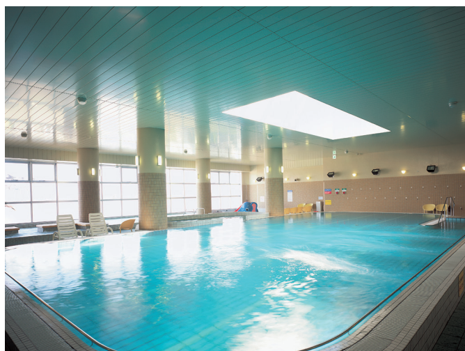
物件名／スパ 使用場所／プール 天井
