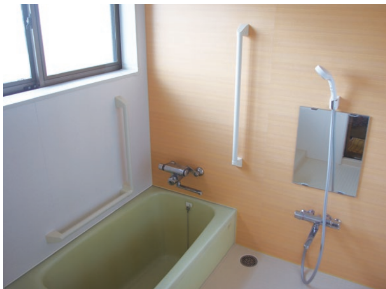
施工例 手すり 左面 L型600、右面 I型 800 壁面 アルミバレージ 左面 [NC]、右面 [TK] 床面 あんから[V]
