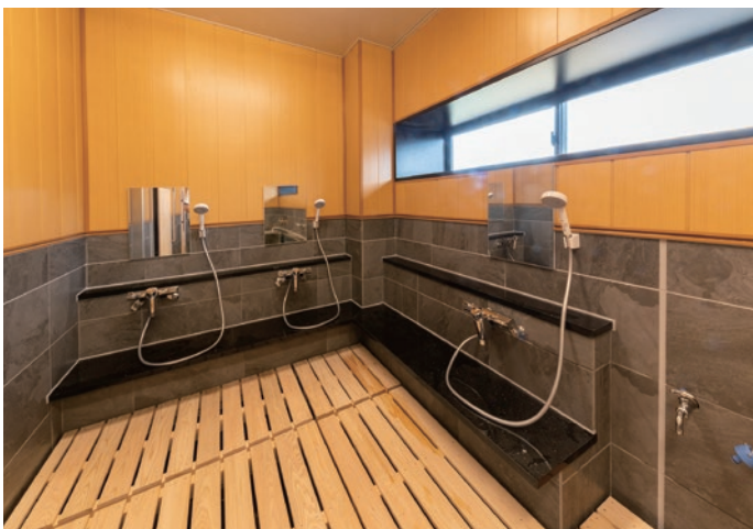
物件名/温泉 (使用場所/浴室 天井・壁)
