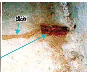
こうした、型枠固定金具の腐食部分は、シロアリが更に侵入しやすくなります。
