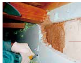
シロアリ侵入箇所 (断熱材をはがした部分)
