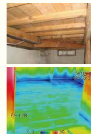
床下断熱リフォーム前
