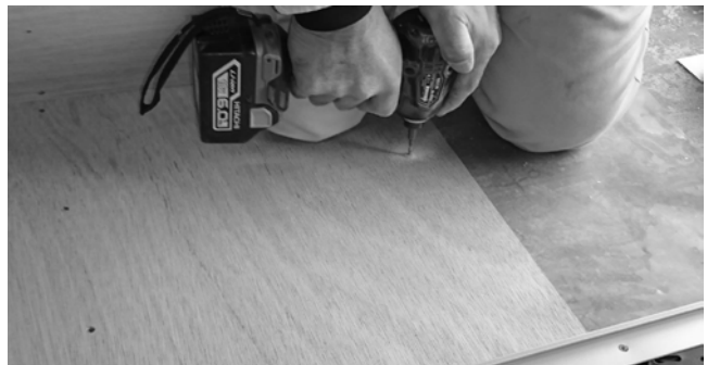
④スロープ面を介してスラブに下穴をあけ、コンクリートビスを打ち込んでください。ビスの打ち込み過ぎにご注意ください。穴の位置は参考納まり図をご確認ください。
