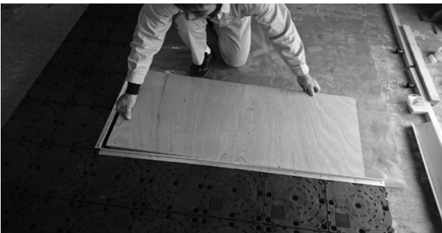
③スーパーUダインNを塗布したOAフロアスロープを設置し、コンクリートスラブ面に圧着してください。
