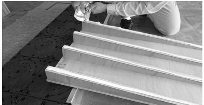
②OAフロアスロープの支持脚部分にスーパーUダインN(接着剤)を塗布してください。OAフロアスロープ2個につき、スーパーUダインNを1袋使用します。
