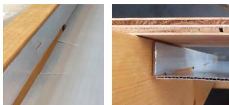
左右の折り目に3箇所ずつ入っているスリット位置で留める。Uタイプが野地板下に通気層を確保。
