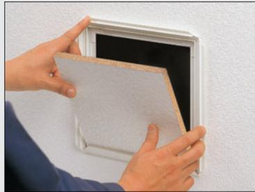
はめ込む際に、カバーで内蓋が傷付かないように指で押し広げながら下側よりはめ込みます。
