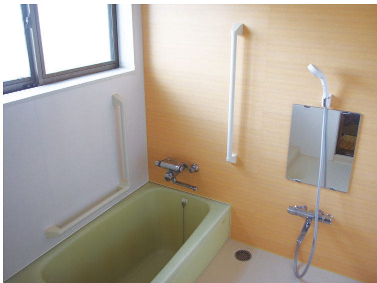
施工例 手すり 左面 I型 600、右面 I型 800 壁面 アルミバレージ 左面 [NC]、右面 [TK] 床面 あんから [V]
