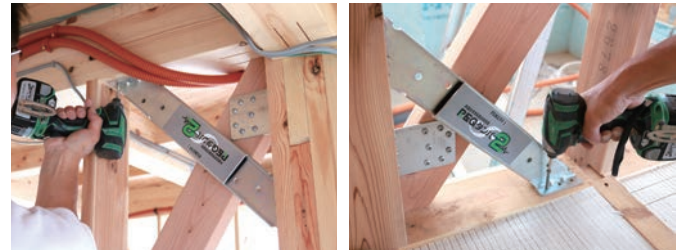
付属のビスを用いて柱や土台・梁に容易に取付けが出来ます。
